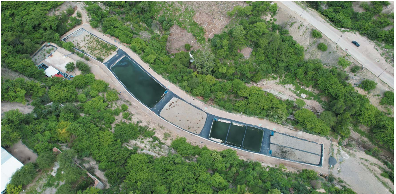
Humedal Construido para Tratamiento de Aguas Residuales de Nuevo Real del Limón
