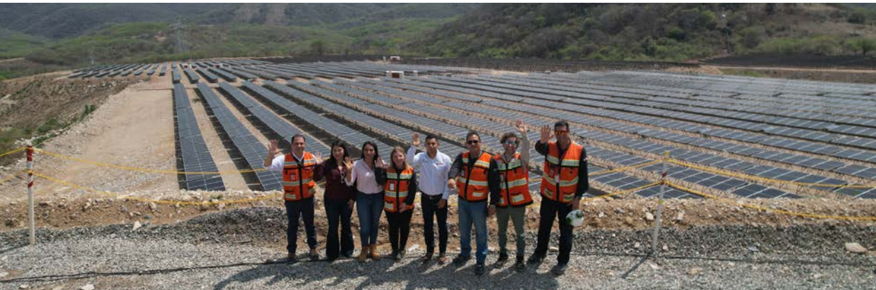
Inauguración de la planta solar Plena Sol de 8.45 MW en el Complejo Morelos
