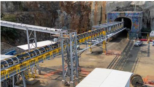
El transportador de banda del Túnel Guajes
