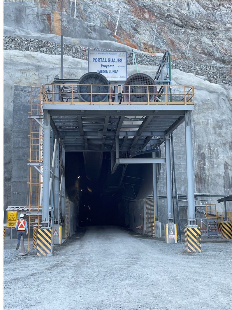
Guajes Tunnel Portal
